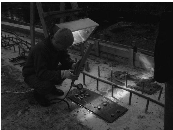
Рис. 38. Инъектирование трещины ручным насосом
