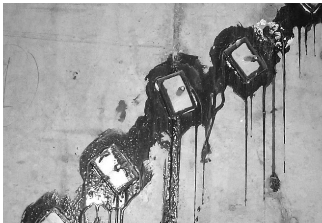
Рис. 39. Инъектирование трещин по высоконапорной технологии
