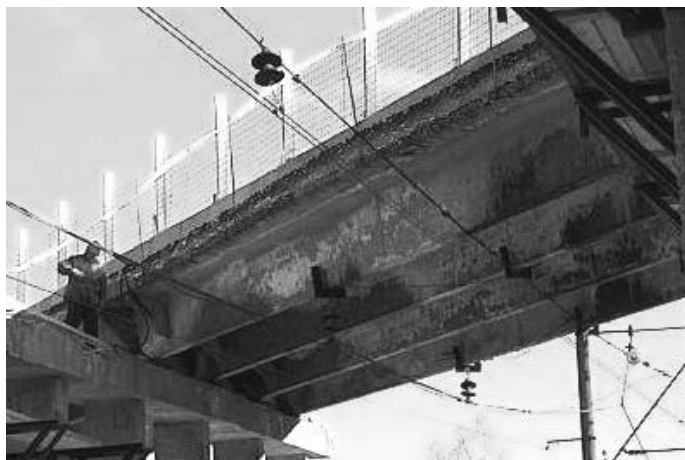
Рис. 7. Разрушение бетона пролетного строения
