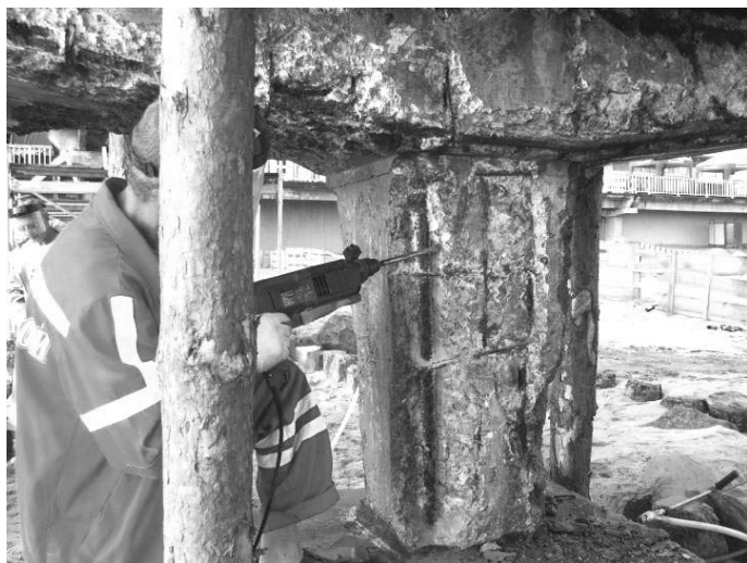
Рис. 20. Подготовка бетонной поверхности опоры с помощью перфоратора
