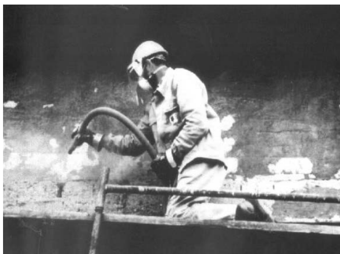
Рис. 22. Очистка поверхности с помощью пескоструйной установки
