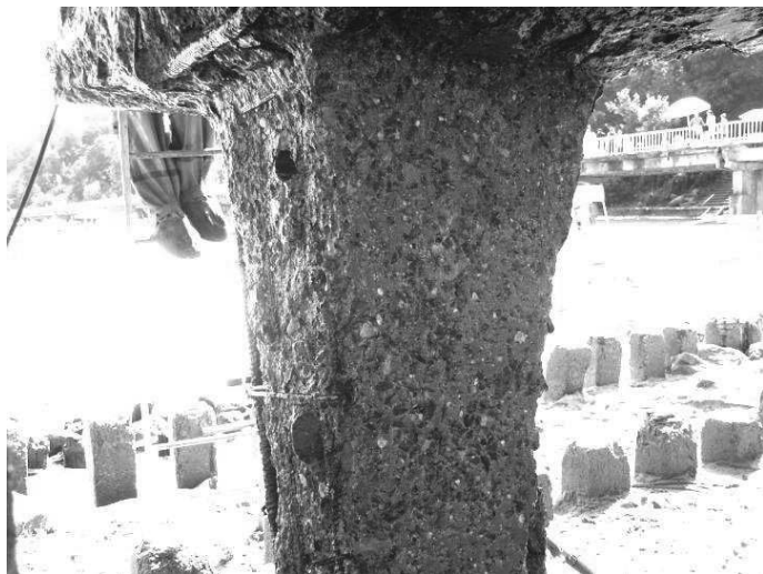
Рис. 19. Бетонная опора, подготовленная к ремонту
