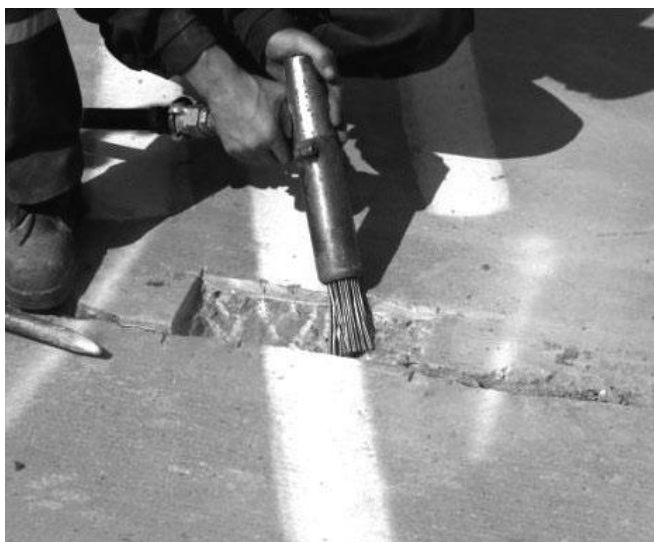
Рис. 14. Подготовка бетона игольчатым пистолетом
