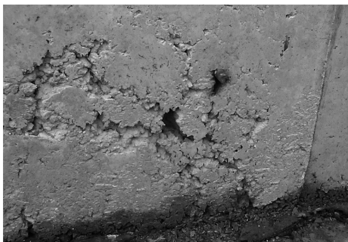
Рис. 4. Непровибрированные участки стены
