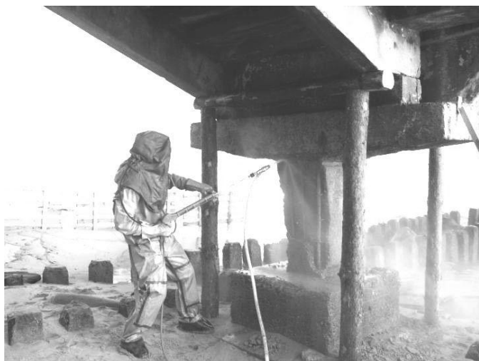
Рис. 21. Очистка поверхности бетона помощью водопескоструйной установки
