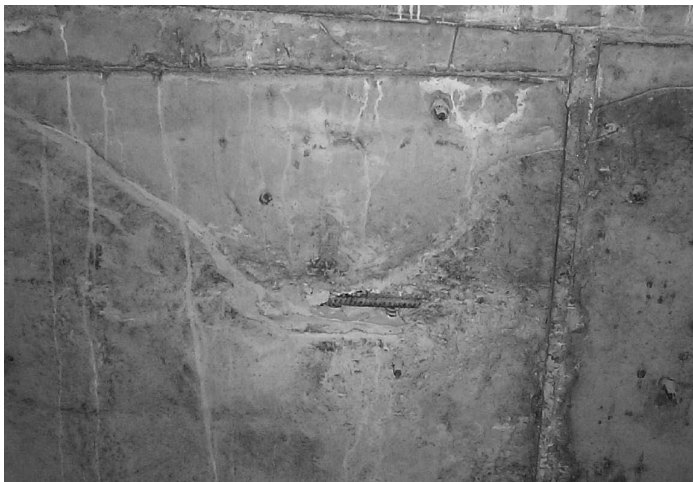
Рис. 1. Участок стены с оголенной арматурой
