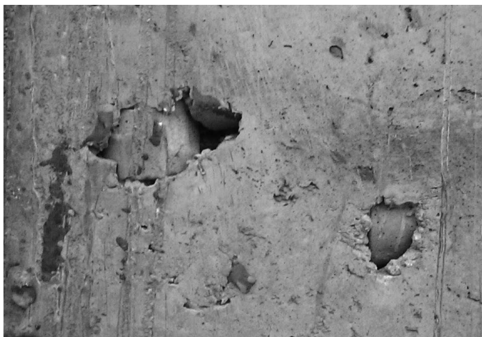
Рис. 5. Зависание бетонной смеси в зоне «сухарей»
