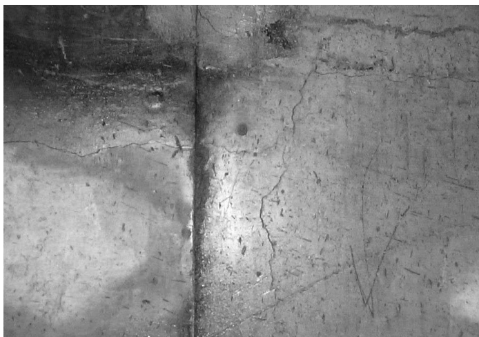
Рис. 6. Усадочные трещины на поверхности стены автодорожного тоннеля
