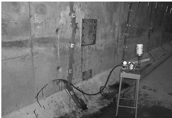
Рис. 39. Инъектирование трещин по высоконапорной технологии
