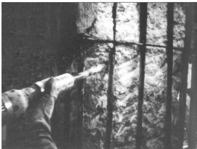
Рис. 13. Подготовка поверхности с помощью бучарды
